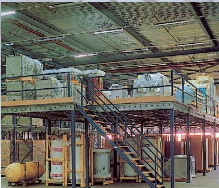
Tussenvloer met bordestrap
